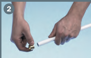
2 Introducerea manșonului pe țevă
