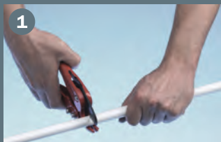
1 Tălerea cu un cutter special
